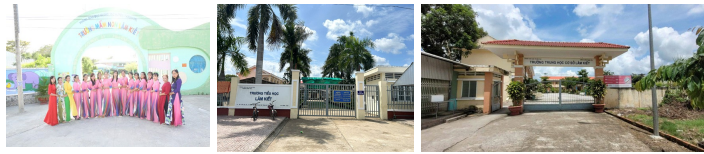
CÔNG TRÌNH HIỆN TRẠNG
